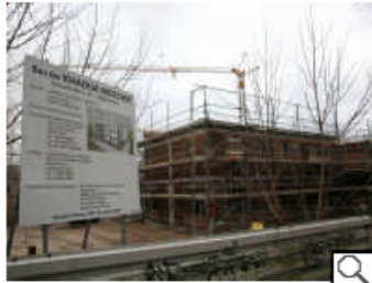
Der Rohbau in Heinersdorf ist fast fertig. - Foto: Thilo Rückeis Von Claudia Keller 18.11.2007 22:06 Uhr
